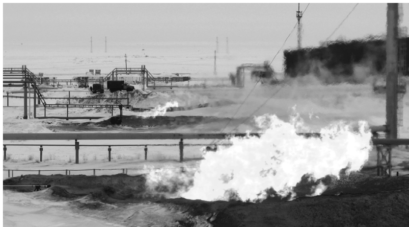
Рис. 1. Горизонтальные факельные установки Юрхаровский газоконденсатный промысел
