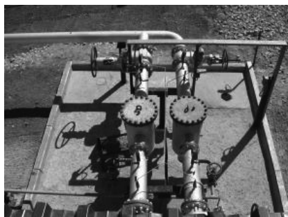
Рис. 6. Фильтр прямого действия
