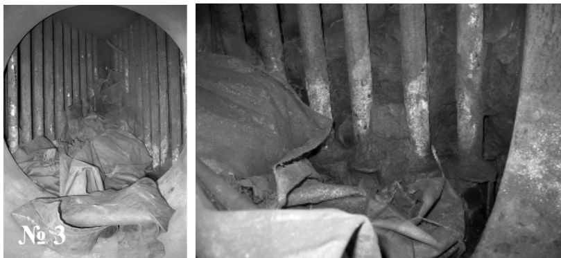
Рис. 7. Результат 1-й промывки пылеуловителя
