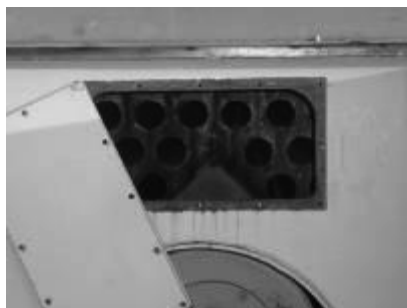
Рис. 2. Жаровые трубы теплогенератора
